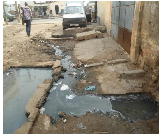
Photo5: connexion des eaux vannes aux réseaux d'eaux pluviales
