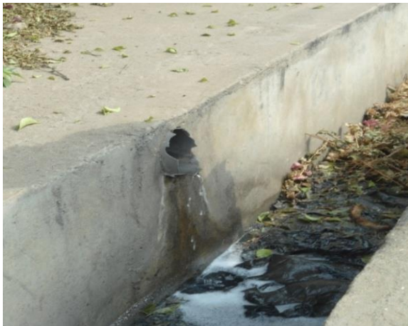
Photo5: connexion des eaux vannes aux réseaux d'eaux pluviales
