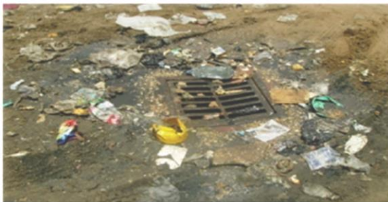
Photo 2 : avaloirs bouchés des restes de cuisines
