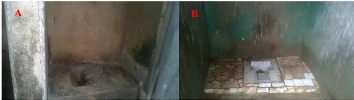
**Figure 23:** Latrine (A) plateforme Samplat (B) plateforme à la Turquie avec carreaux cassés
