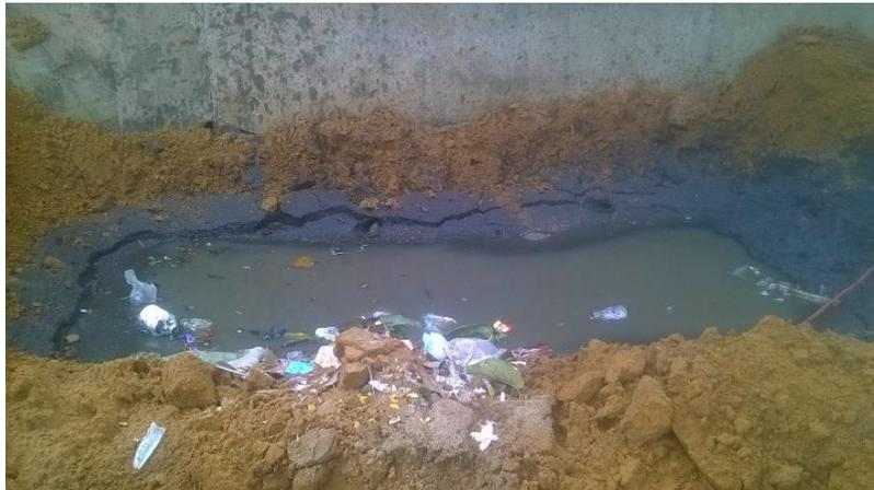
**Figure 18** : Trou creusé pour accueillir les produits d'une vidange manuelle
