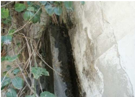
Fuite sur conduite apparente Lycée Lamine Gueye
