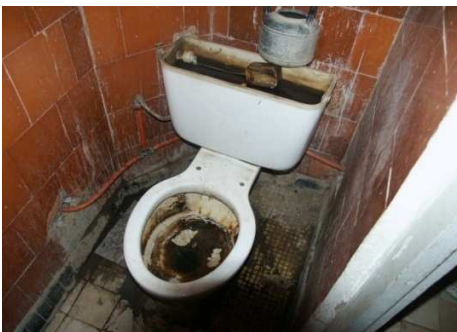
Fuites sur chaise et sur conduite enterrée (Lycée Lamine Gueye de Dakar)
