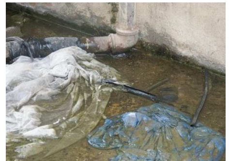
Fuite sur conduite mal réparée (Centre Formation Maritime)
