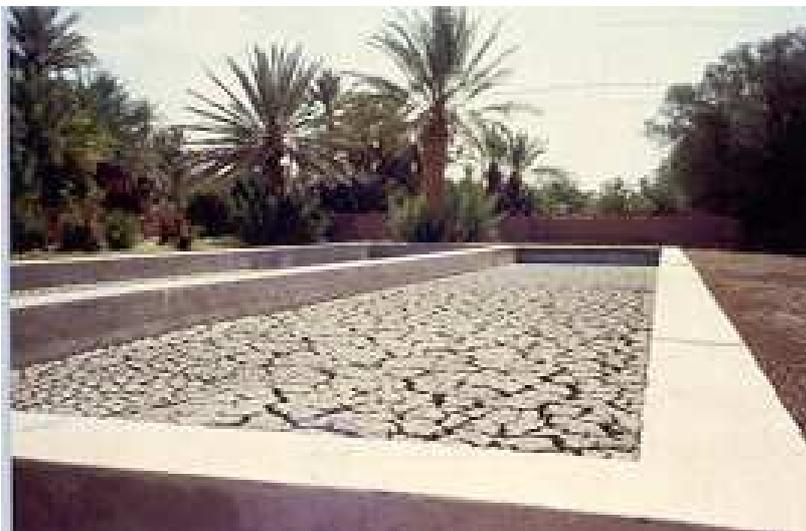
Photo 2 : Exemple de lits de séchage, boues séchées à l'avant plan, Ouarzazate, Maroc
