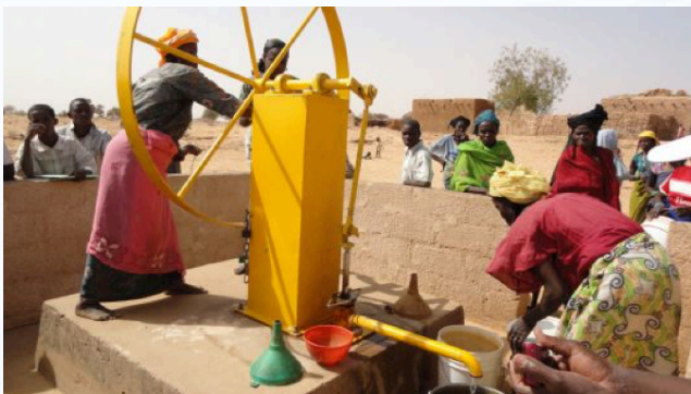
Photo 3 : Pompe hydraulique à motricité humaine à Kornaka. Crédit Photo : PASEAK
