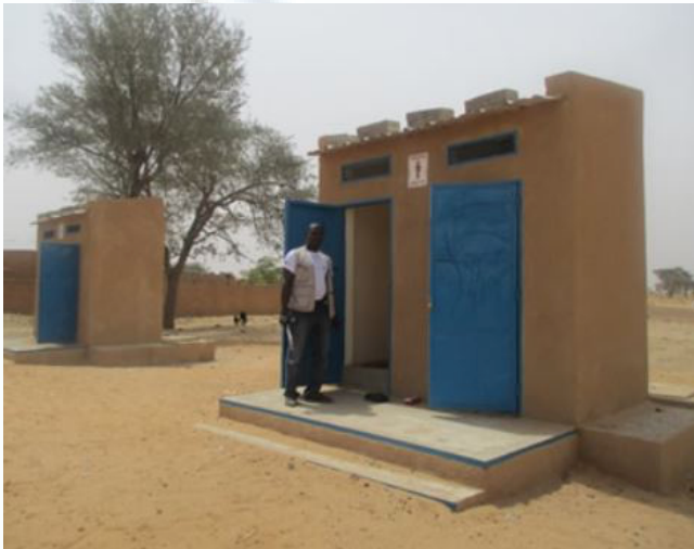
Photo 1 : Latrines pour assainissement autonome à Kornaka. Crédit Photo : pS-Eau
