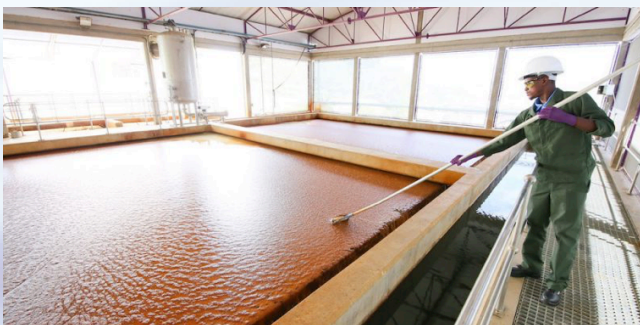
Photo: Station de traitement des eaux usées de Windhoek
