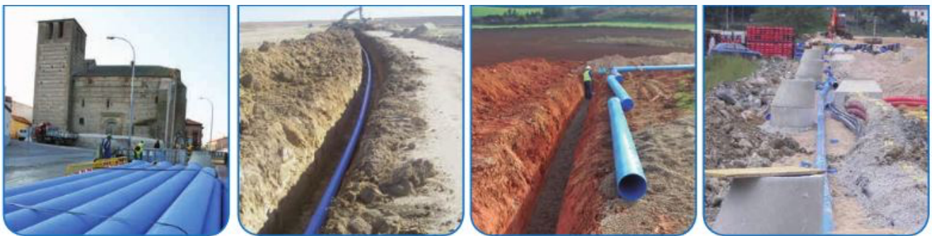
Photo 2 : Canalisations en PVC-BO destinées au transport de l'eau potable, à l'approvisionnement des zones urbaines et industrielles ainsi qu'au remplissage des réservoirs et barrages.
