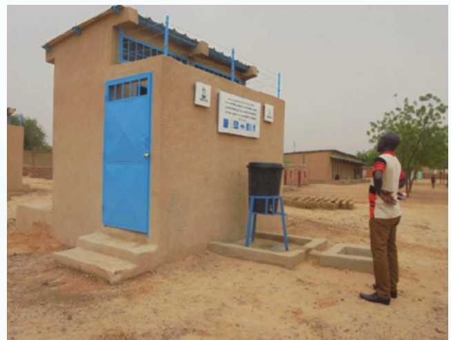
Photo 2 : Latrines en milieu scolaire, livrable du PASEAK. Crédit Photo : pS-Eau
