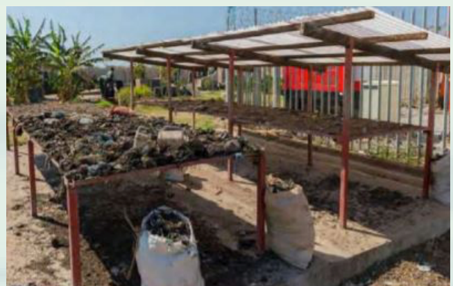
Triage et séchage des déchets solides au FSTP de Kanyama.
