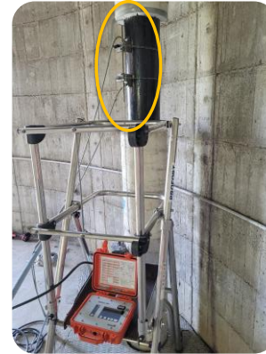
Surveillance débits de nuit en réservoir (conduite acier carbone, revêt. bitumé, capt. 1MHz, 2 TS). Recherche de fuites sur secteurs.
