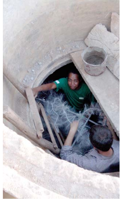
Mise en place d'un massif filtrant dans un filtre anaérobie à Madagascar.
