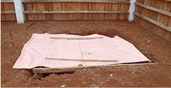
Fosse préparée pour recevoir des boues de vidange dans un site d'enfouissement planté.
