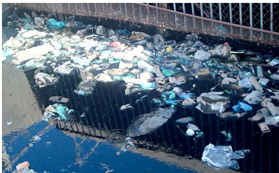
Déchets solides présents dans les eaux usées.
