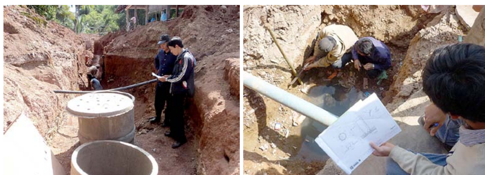
Construction d'un réseau d'égouts au Laos.
