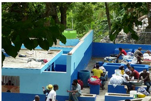
Lavoire du bloc sanitaire du quartier Tête de l'Eau (Haïti).
