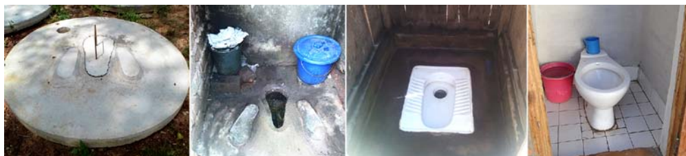
Différents modèles de dalles, de gauche à droite : dalle Sanplat, dalle maçonnée, cuvette céramique dans une dalle maçonnée, chaise anglaise avec sol carrelé.
