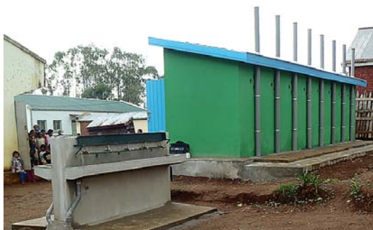
Bloc sanitaire scolaire avec dispositif de lavage des mains à Ambohibary (Madagascar).
