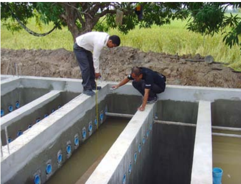
Réacteur anaérobie à chicanes en construction au Cambodge.
