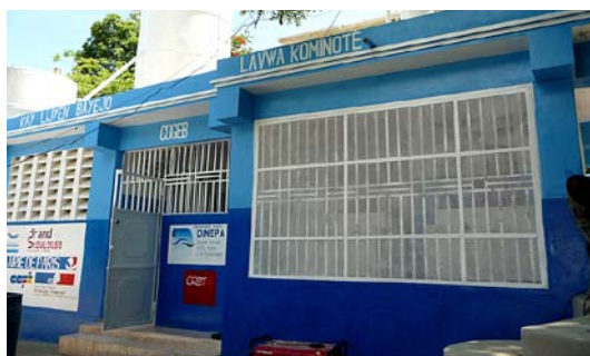
Maison de l'hygiène (« Kay liyèn ») du quartier Baillergeau à Port-au-Prince (Haïti).
