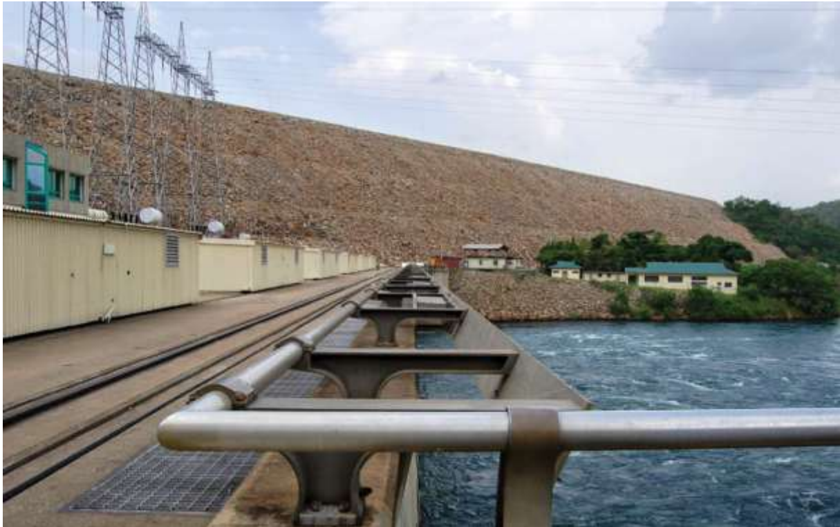
Figure 1 : Station de Captage des Eaux
