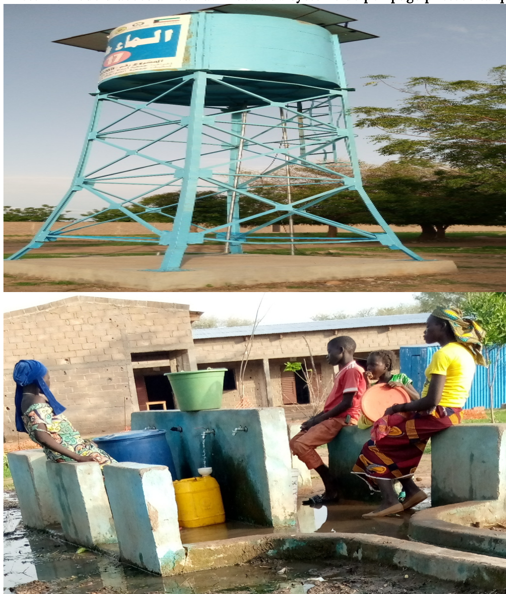
Photo 1 : Mode d'accès à l'eau au niveau du système de pompage photovoltaïque
